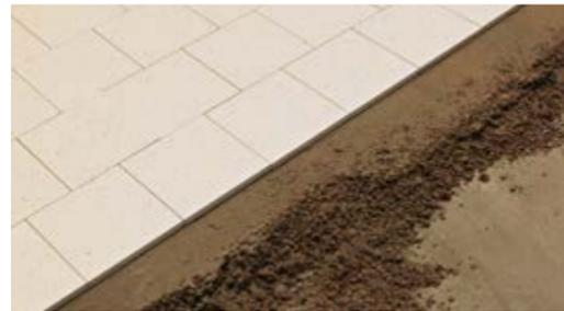
Beispiel für einen Bodenaufbau im Verbund.
