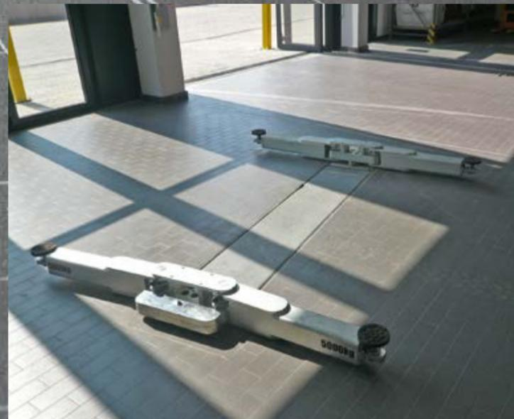
*Eine Feuerwache mit zuverlässigem und hoch belastbarem Boden: Röben VIGRANIT® Feinsteinzeug anthrazit, feuersiegelt, 20 x 10 cm, Oberfläche R12.*
