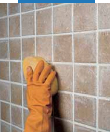
Очистка плитки одинарного обжига с помощью целлюлозной губки
