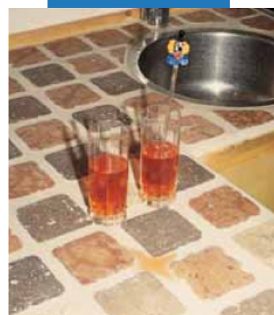
Пример приклеивания и заполнения швов на кухонной столешнице
