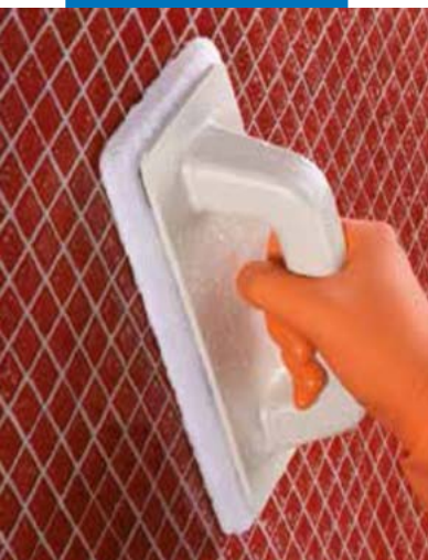
Очистка стеклянной мозаики влажной абразивной губкой Scotch Brite®
