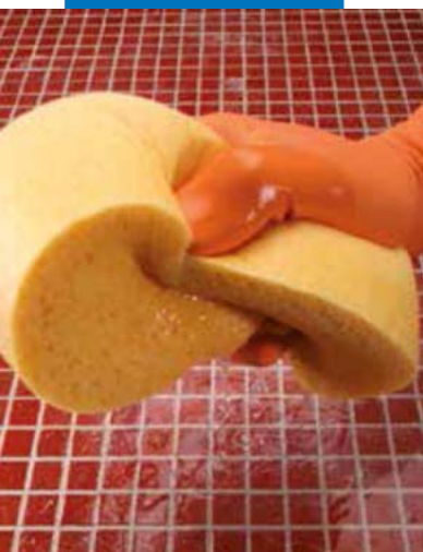
Смачивание поверхности перед очисткой
