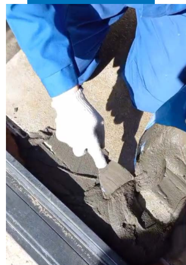
Заполнение штроб Планипатч с песком с толщиной нанесения более 2,5 см
