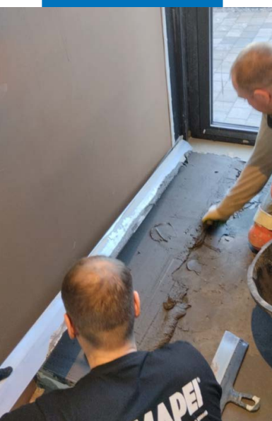
Ремонт и выравнивание входной зоны
