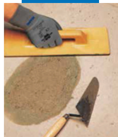
Ремонт пола: заглаживание поверхности
