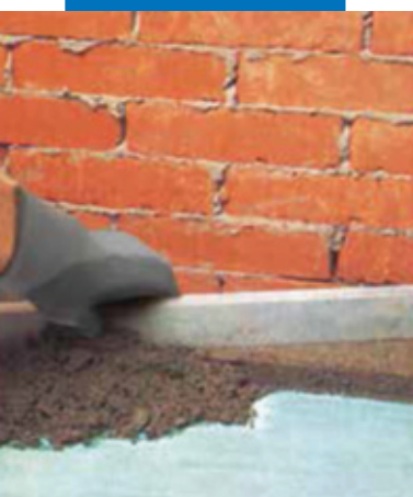
Укладка цементной стяжки с добавлением Planicrete
