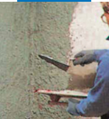
Нанесение адгезионной штукатурки с добавлением Planicrete
