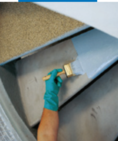
Нанесение первого слоя Маресоат I 24 на бетон
